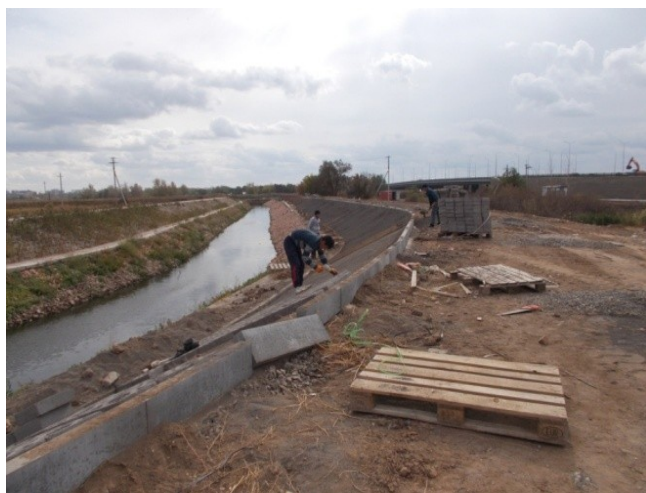
Ведутся работы по укреплению берега и строительство набережной ручья.
